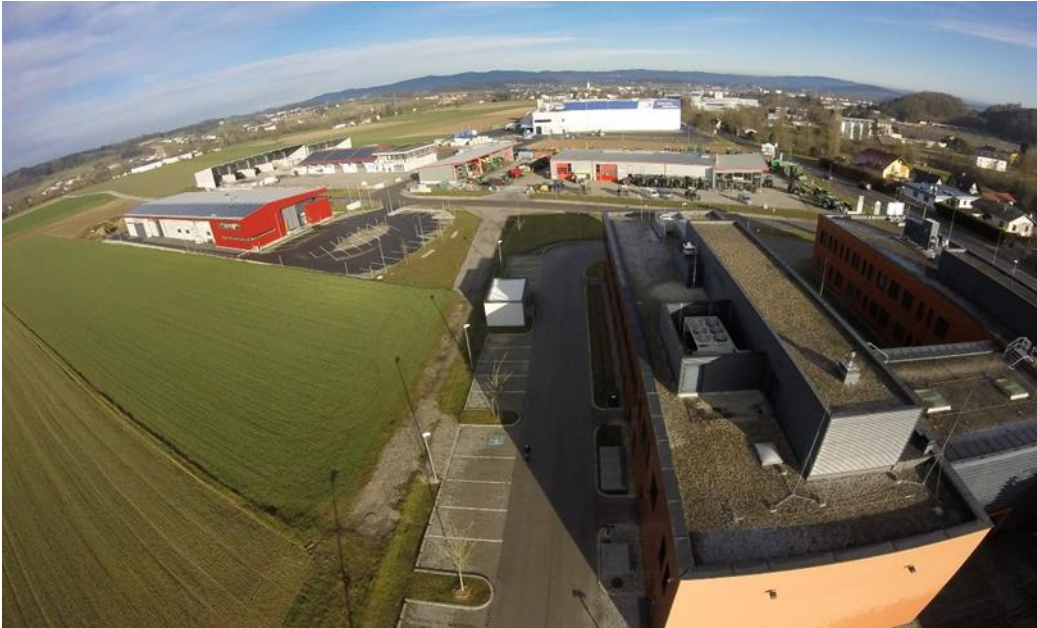
Abbildung 1: Luftaufnahme des TFZ-Wieselburg und des neuen Feuerwehrhauses mit PV-Anlage (Copyright BEST GmbH; Michael Stadler)
